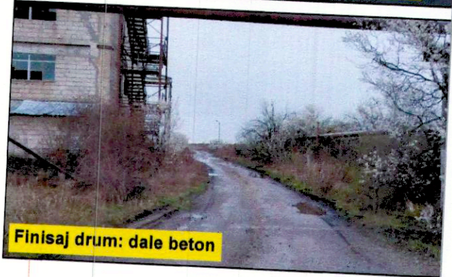
Finisaj drum: dale beton
