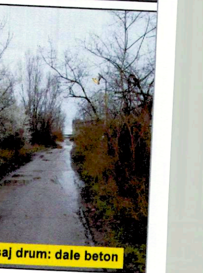
Finisaj drum: dale beton
