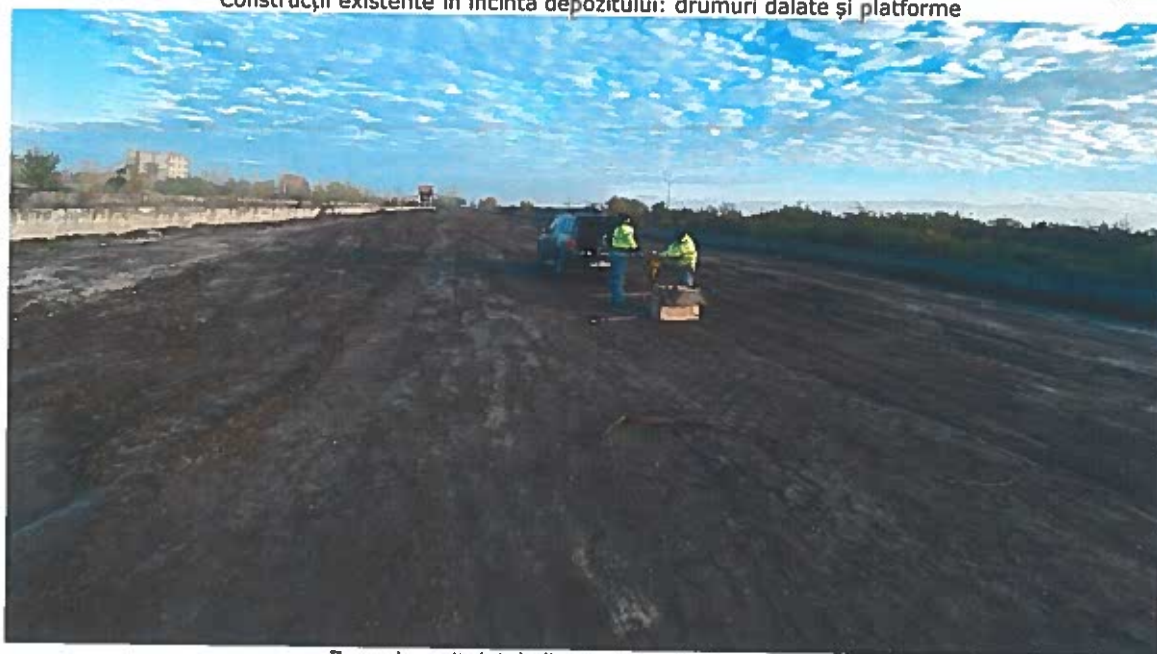
Zona depozitului de lignit şi vecinătăţile acestuia
