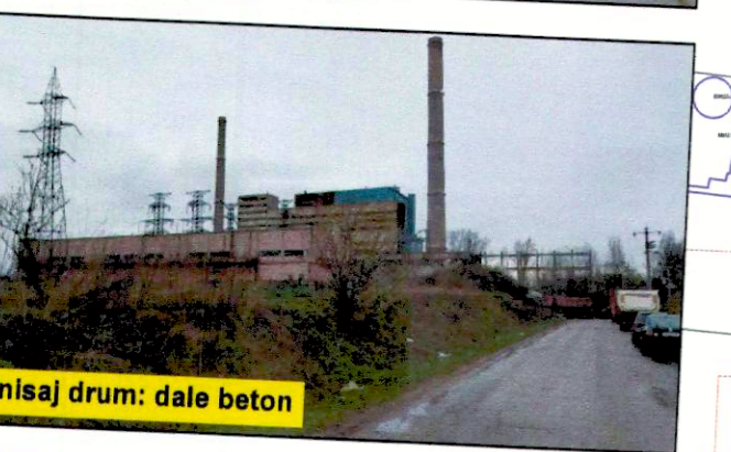
Finisaj drum: dale beton
