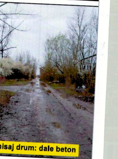
Finisaj drum: dale beton
