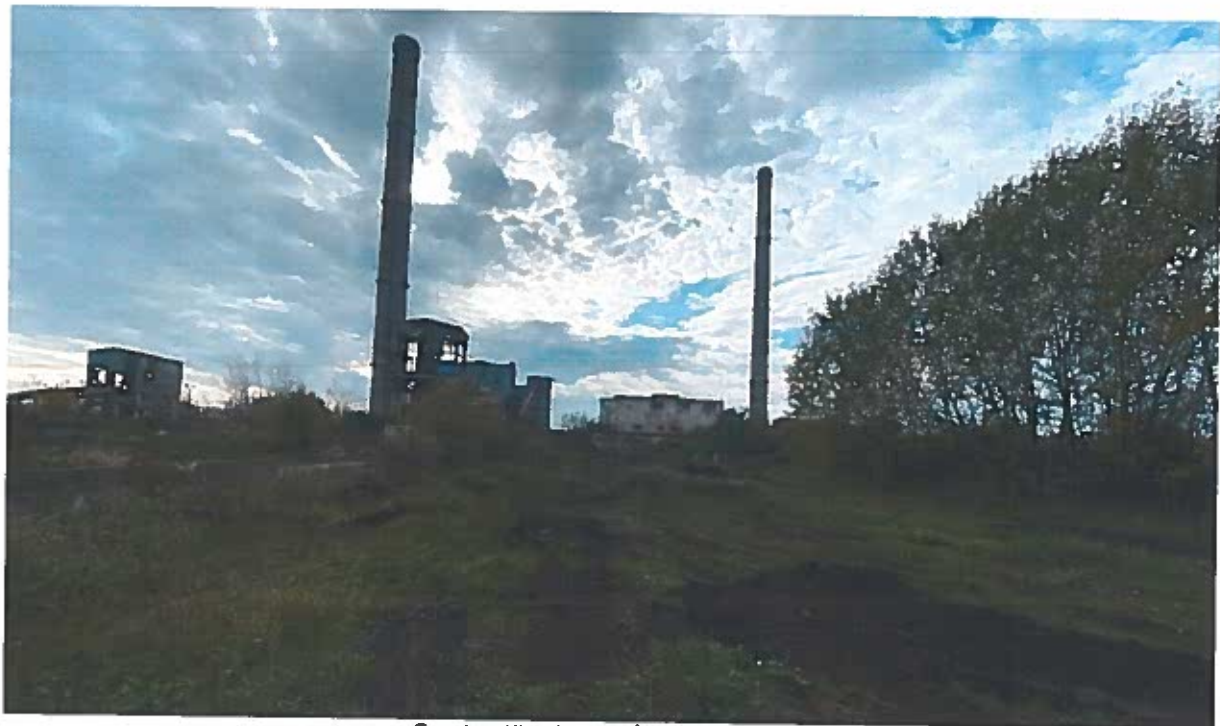
Construcții existente în amplasament
