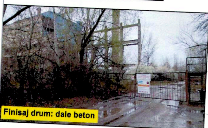
Finisaj drum: dale beton
