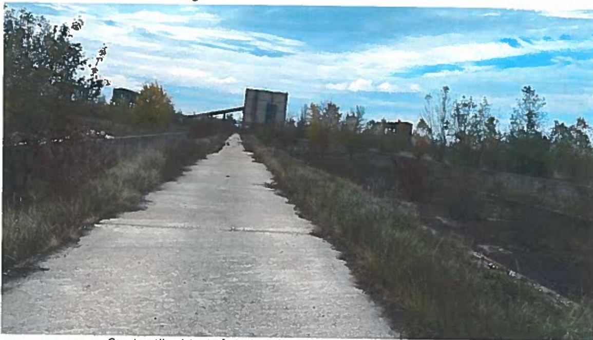
Construcţii existente în incinta depozitului: drumuri dalate şi platforme
