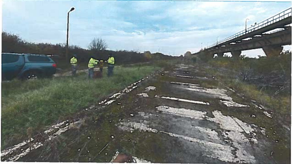
Platforme și drumuri în incinta CET
