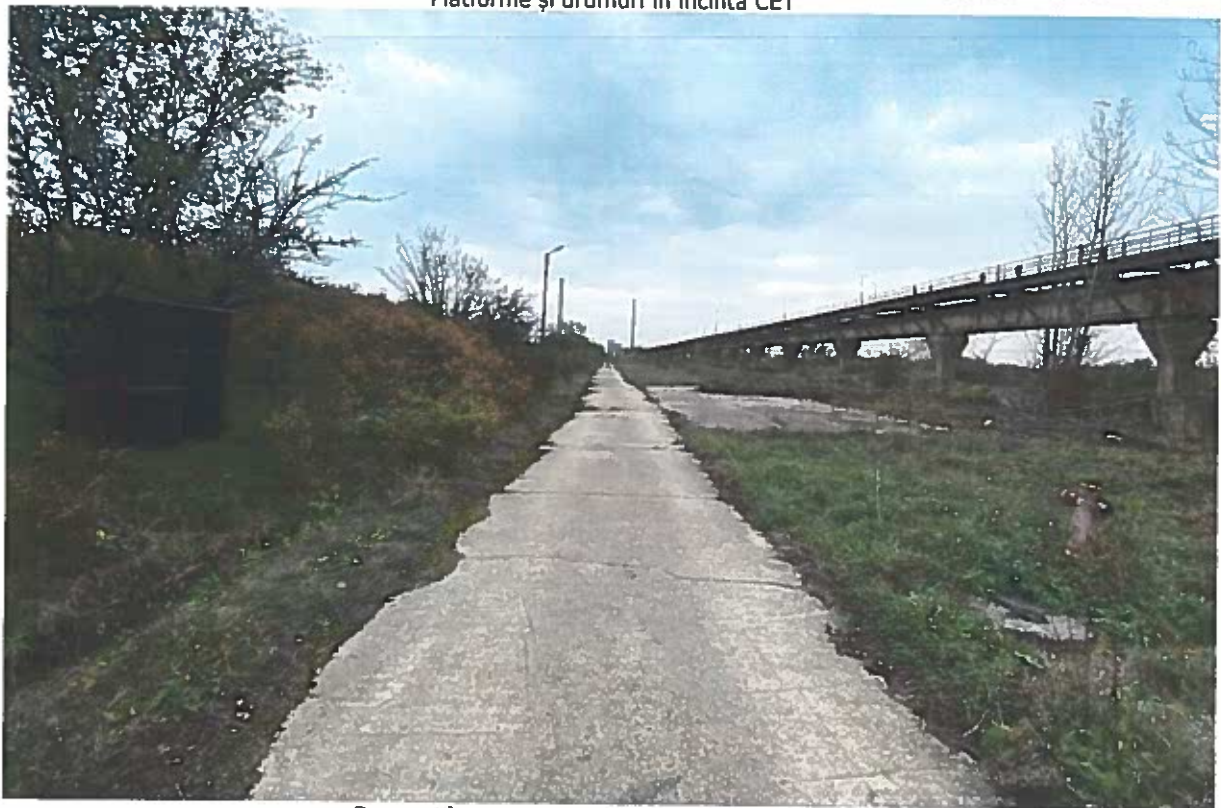
Drumuri în incinta CET; rețele utilităților și hidranți
